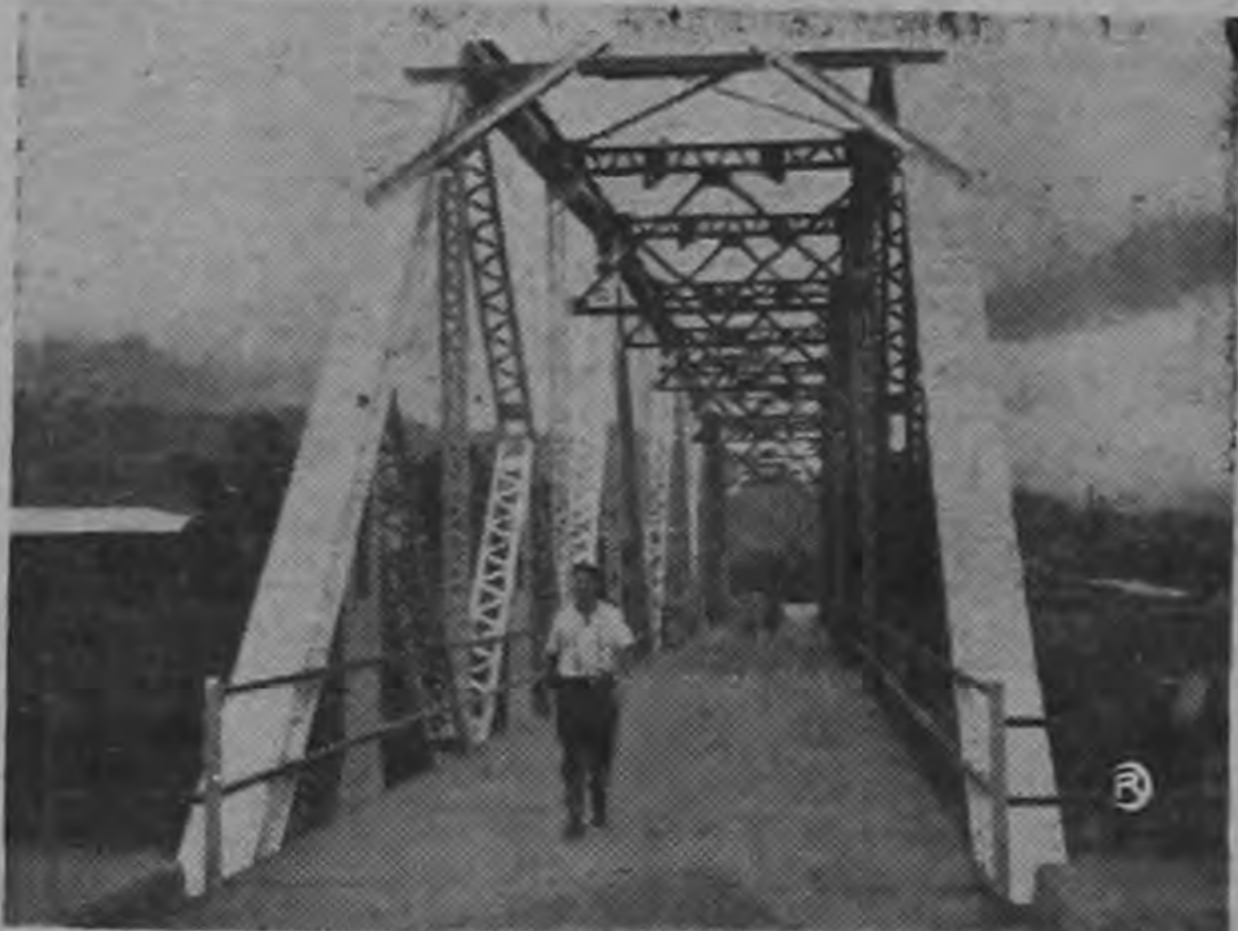
ABREN AL TRAFICO PUENTE DE TURRIALBA. He aquí el hermoso puente sobre el río Turrialba, completamente refaccionado y listo para soportar el peso del intenso tráfico que hay entre la ciudad y las poblaciones del este de Turrialba. Las reparaciones han sido efectuadas a través de varios meses por cuadrillas del Ministerio de Obras Públicas. Foto Céspedes.
